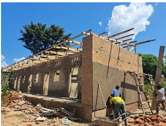
Rohbau der Werkstätten
